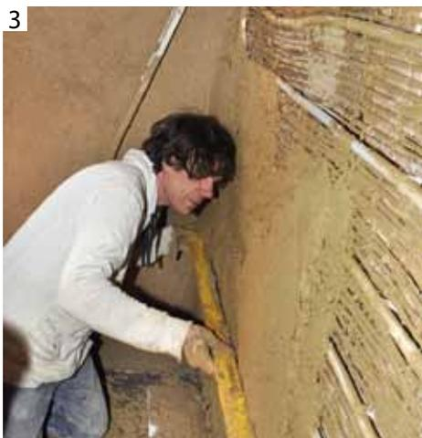
Pour dresser l'enduit d'aplomb, on peut réaliser des rails verticaux (1), à l'aide du niveau à bulle (2). Ensuite, on remplit l'espace intermédiaire de mortier, puis l'on égalise à l'aide d'une règle que l'on fait glisser le long des rails (3).
