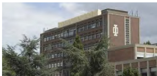
Exemple de bâtiment à réhabiliter dans le cadre du plan campus
