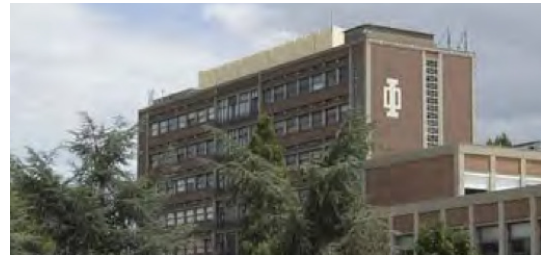
Exemple de bâtiment à réhabiliter dans le cadre du plan campus
