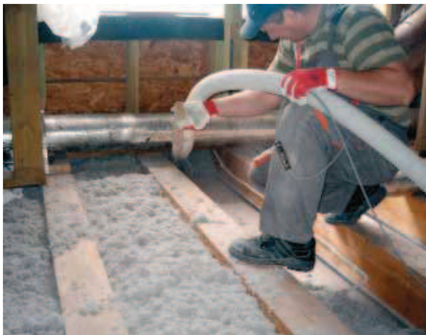
Soufflage en combles
