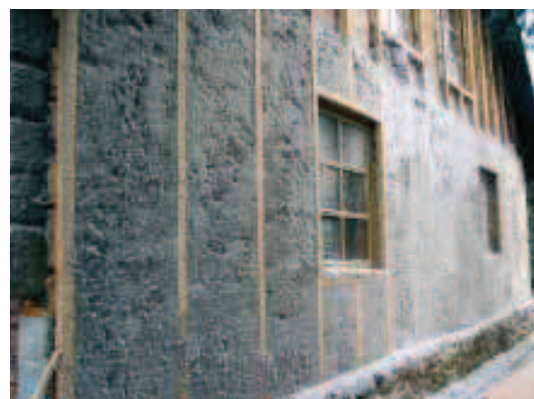
Isolation extérieure par projection
