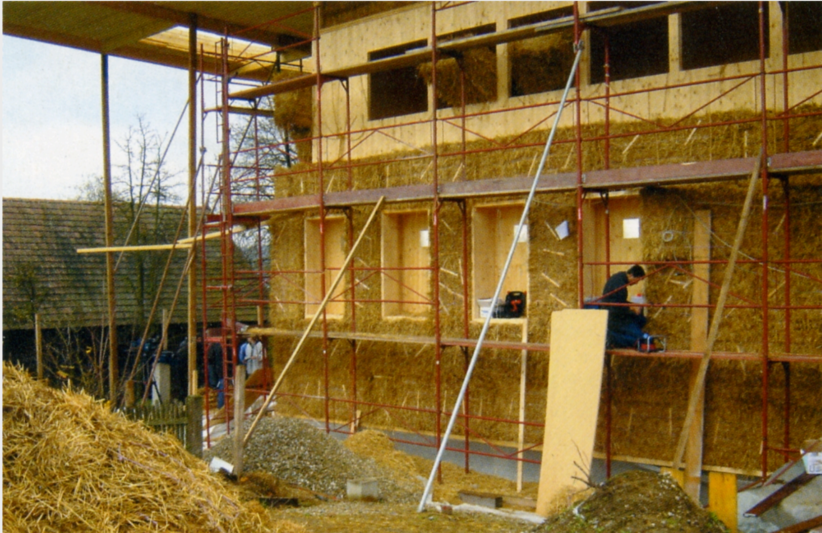
S-House Architecte : J. Schneider
