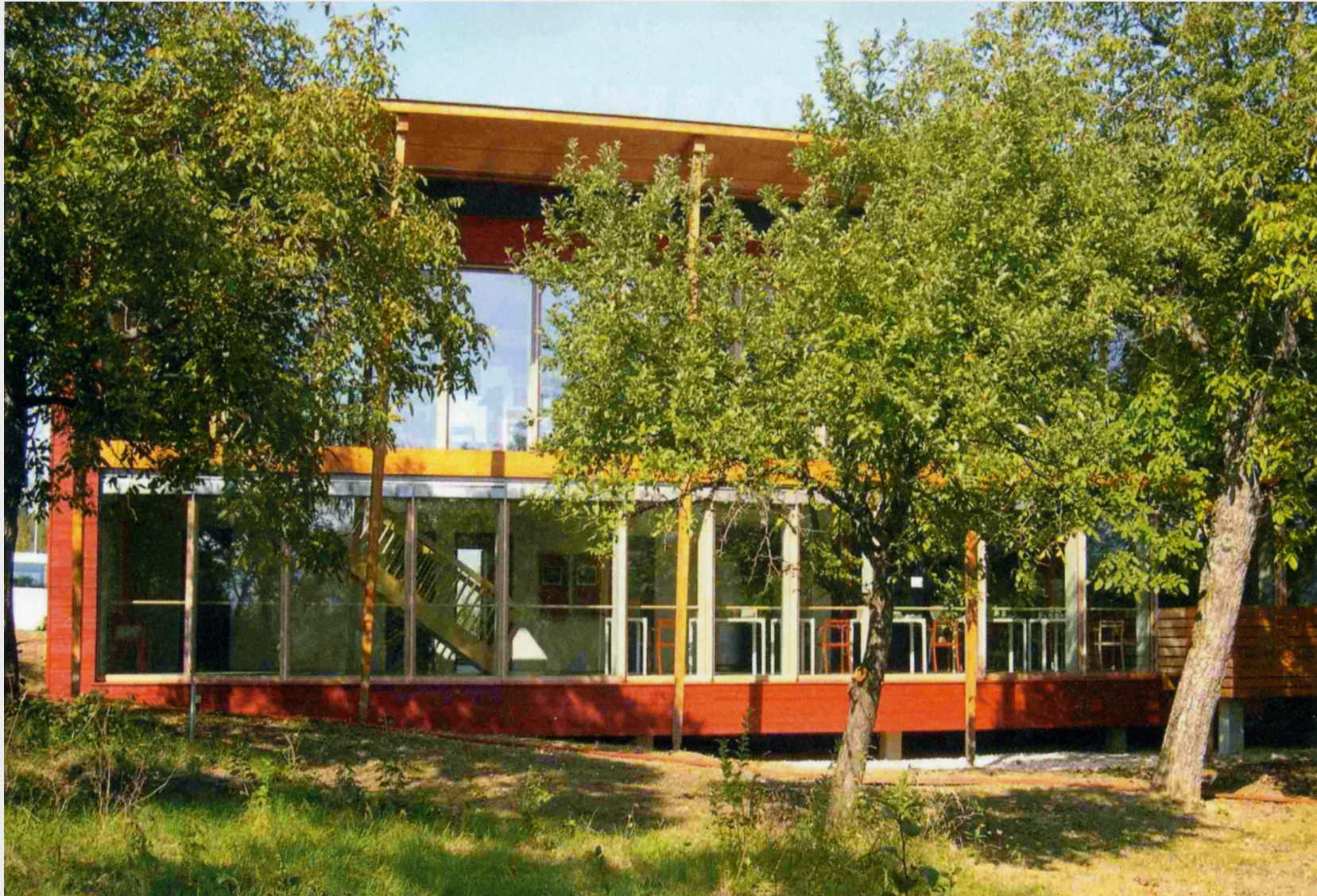
S-House Architecte : J. Schneider
